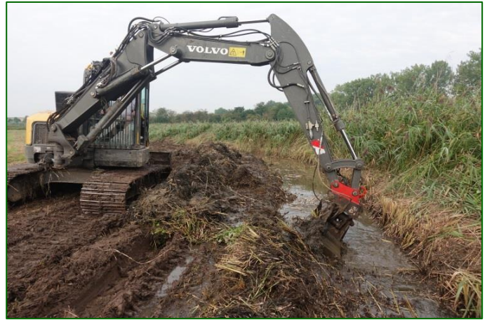
Neuprofilierung des Grabenabschnittes
