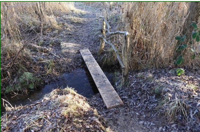
Bau einer neuen Brücke über unseren Bachlauf.
